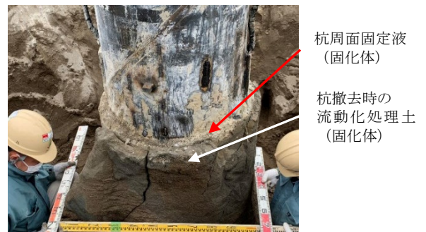
写真1 試験杭2の杭径調査
