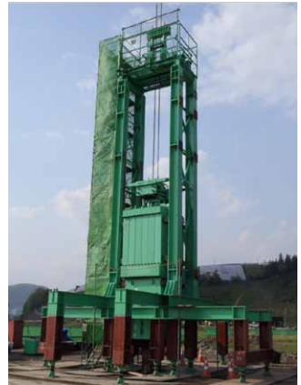
写真-1 急速載荷試験実施状況
